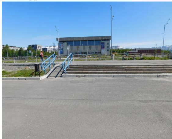
Территория, прилегающая к зданию
