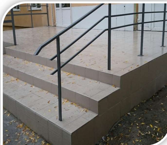
Замена плиточного покрытия
