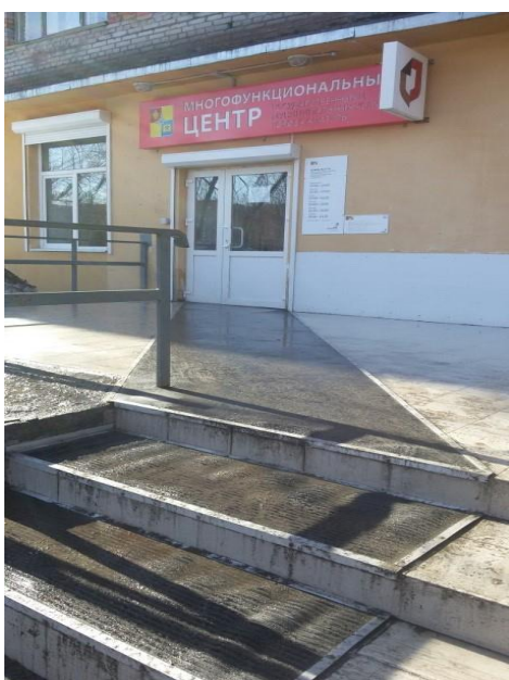
Установка противоскользящего покрытия
