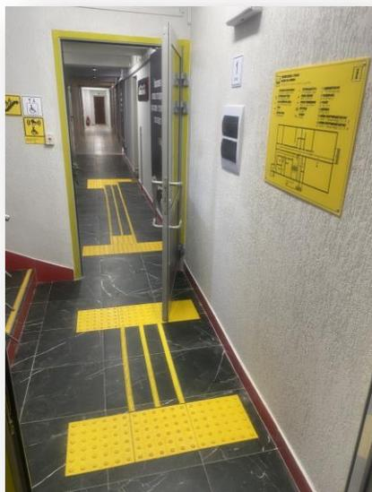
инвалидов» спортивный молодежный центр СОПКИ. СПОРТ полностью адаптирован для инвалидов: расширены дверные проемы и демонтированы все пороги, произведен монтаж специализированных покрытий и механических дверей, произведено переоснащение внутренних лестниц, смонтированы
